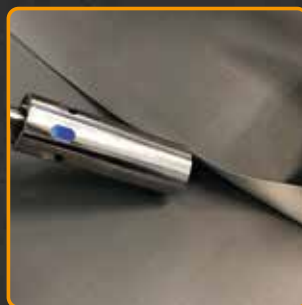
VERSCHWEISSUNG VON DACHBAHNNEN
