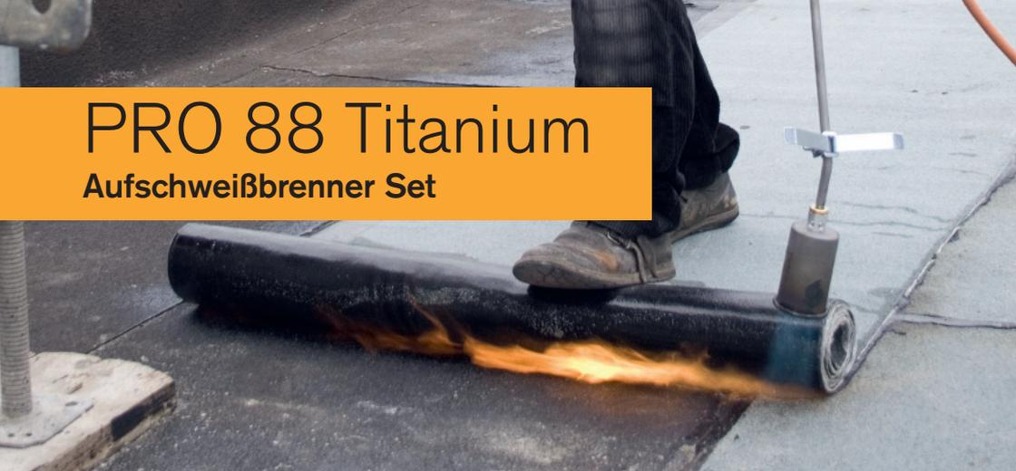
Das PRO 88 Titanium Aufschweißbrenner Set wurde speziell auf die Bedürfnisse von Dachdeckern zugeschnitten. Es besteht aus einem kraftvollen Aufschweißbrenner mit einer Gesamtlänge von 850mm und einem kurzen Kantebrenner für Detailarbeiten an Ecken und Kanten. Durch die ebenfalls im Set enthaltenen Schnellkupplungen kann sehr schnell zwischen kurzem und langen Brenner hin- und her gewechselt.
