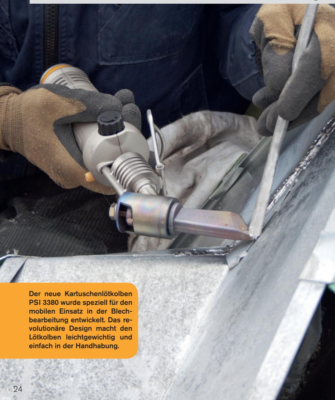
Der neue Kartuschenlötkolben PSI 3380 wurde speziell für den mobilen Einsatz in der Blechbearbeitung entwickelt. Das revolutionäre Design macht den Lötkolben leichtgewichtig und einfach in der Handhabung.
